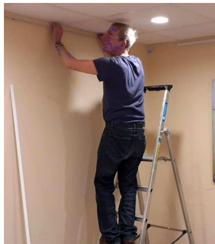
Montage von Bilderleisten
