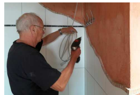
Helmut bei Montagearbeiten
