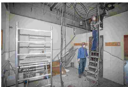
Rückbau der Decken
