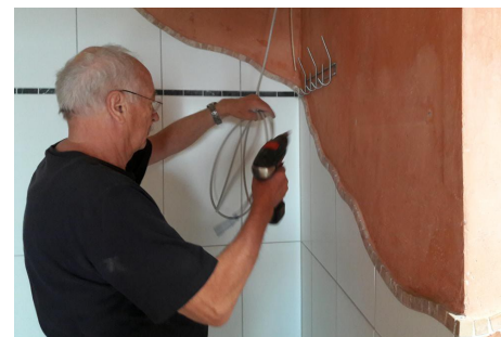
Helmut bei Montagearbeiten
